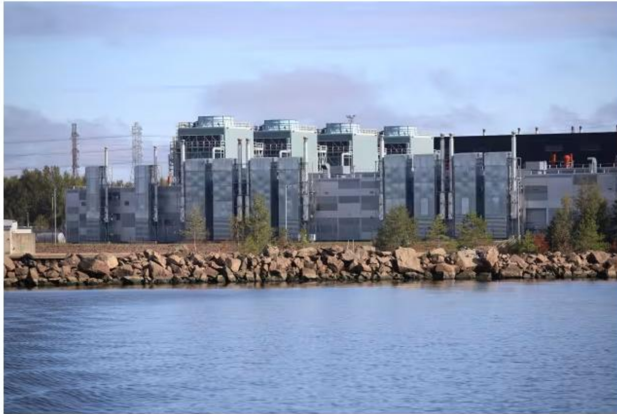
Googlen datakeskus Haminassa sijaitsee meren rannalla. Kuva: Antro Valo / Yle
